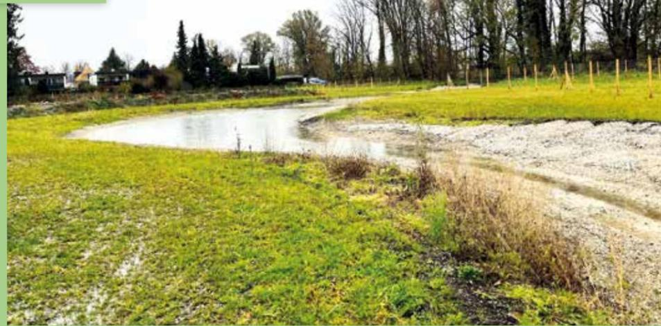
Die Baustelle ruhte einige Zeit, da nach Fertigstellung der Erdarbeiten eine Probeflutung durchgeführt werden sollte, um den korrekten Wasserfluss zu überprüfen. Da die Würm im Sommer sehr wenig Wasser führte, wurde die Probeflutung in die „nasse Jahreszeit“ auf Ende Oktober verschoben und mittlerweile auch erfolgreich durchgeführt.
